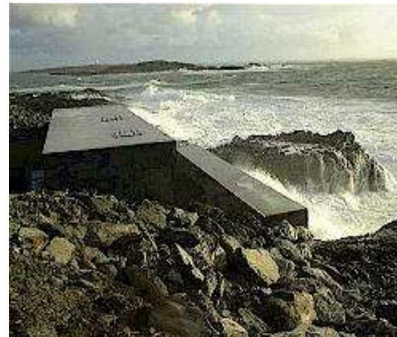
Ilustración 3 Dispositivo de columna de agua en Islay. Fuente: Wavegen.
