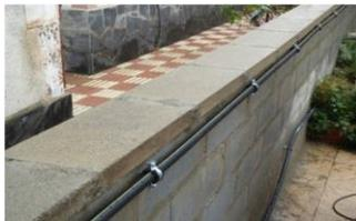
Las distancias mínimas de separación de una tubería vista a conducciones de otros servicios vistos (conducción eléctrica, de agua, vapor, chimeneas, mecanismos eléctricos...), deben ser de **3 cm, tanto en curso paralelo como en cruce.**
